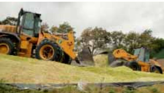
Dat shovels niet alleen worden ingezet in grondwerk blijkt wel uit deze foto.
